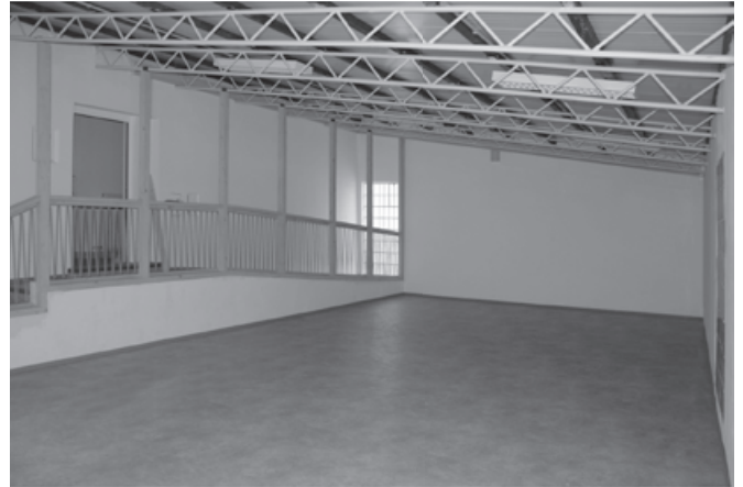
Der Spielraum mit neuem strapazierfähigem Fußboden und neuem Geländer.
