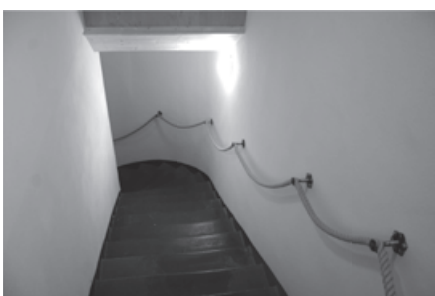
Ein neuer Handlauf im Treppenhaus.
