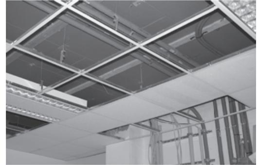
*Die Aufhängung für Decke und Beleuchtung ist montiert.*
