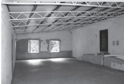
Auf unserer Heimbaustelle hat sich im Sommer viel getan: Im großen Raum im Erdgeschoß wurde die Fußbodenheizung und der Estrich verlegt, Materiallager und Sporthalle haben ein neues Dach und zwei neue Fenster, hinterm Haus steht die neue Stützmauer, die Trainagen ums Haus sind ausgeschottert und die Lagerwiese ist planiert.
